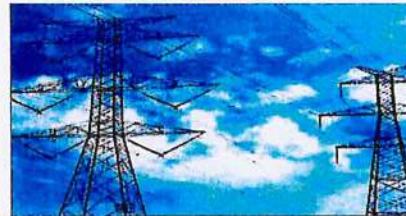
เสาไฟฟ้า
